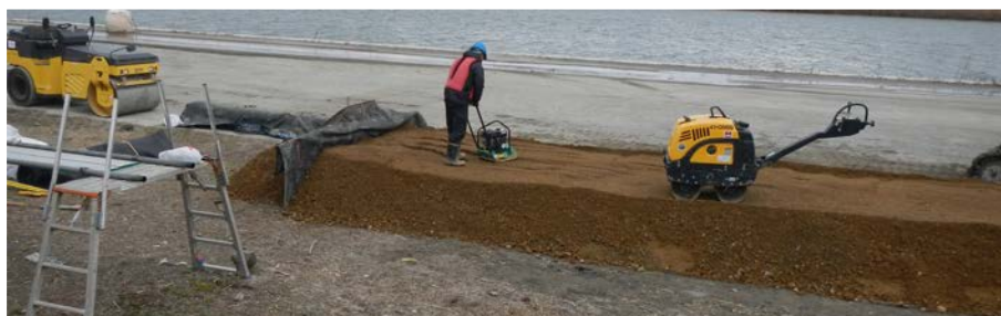
写真-5.1 堤体基礎の締固め
