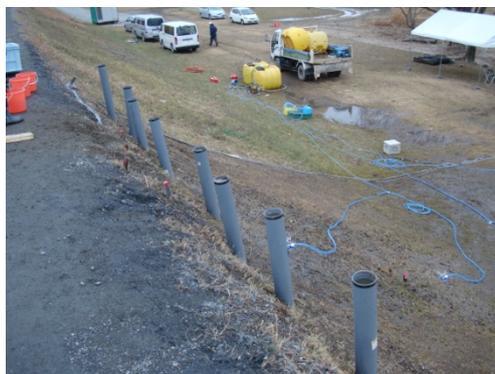
図 5.3.7 堤防法肩における定水位等試験の様子
