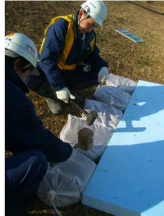
図 4.3.9 EPS 仮設ステージと土のうによる目地詰め
