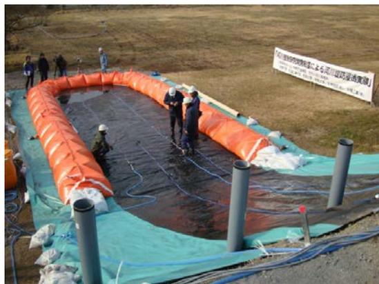
図 5.3.14 透気遮水シート敷設状況
