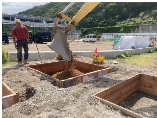
写真4 試料の巻き出しの様子(その2)
