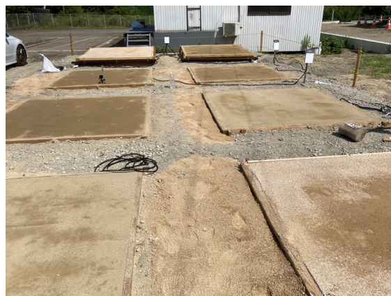
写真6 整地後の様子
