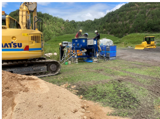
写真3 まさ土団粒化改良の攪拌の様子
