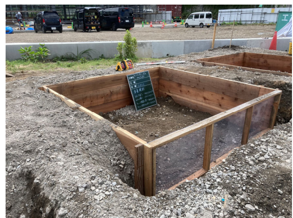
写真1 実験サイトの杉板の枠と塩ビ板
